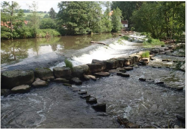
Wehr mit Beckenpass an der Fulda, Goppelmühle in Pfordt
