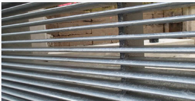
Horizontalrechen an der Lahn, Klinkelsche Mühle/Gießen
