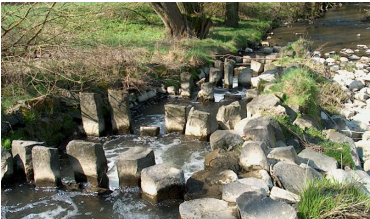
Fischaufstiegsanlage, welche nach dem korrekten Einstellen der Schütztafel wieder ausreichend Wasser erhielt
