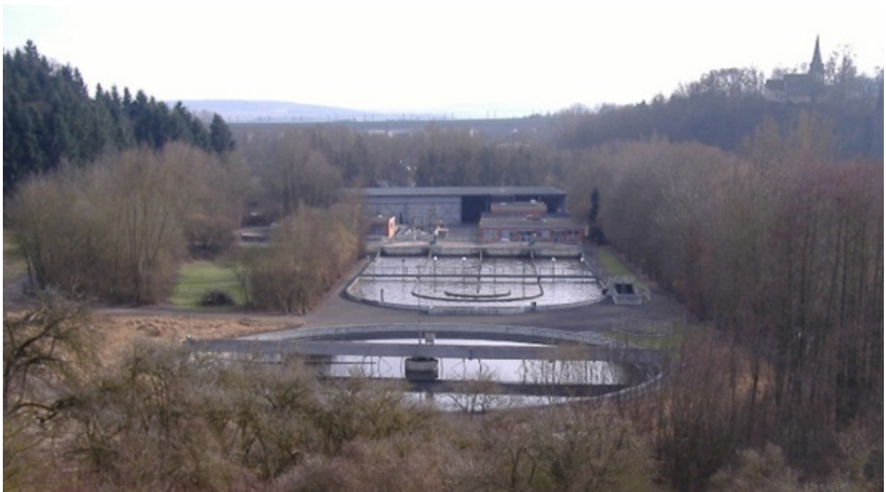
Kläranlage Niederbrechen vor dem Umbau.
