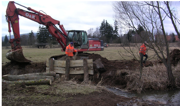
Renaturierung des Waaggrabens bei Grebenhain
